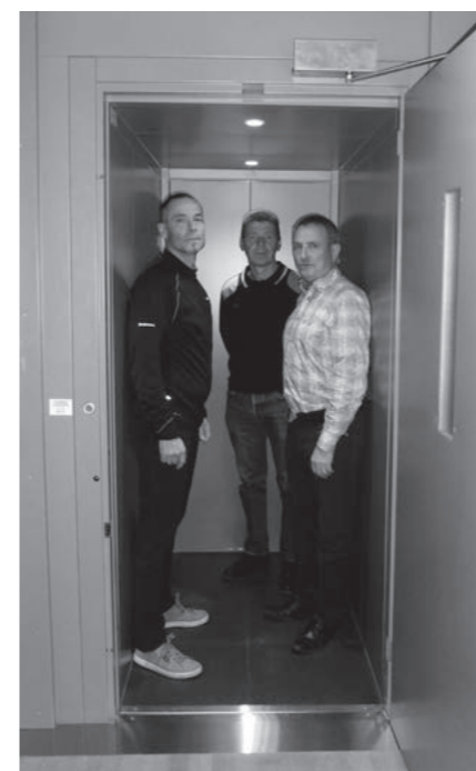
Mise en accessibilité de la mairie.
