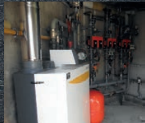
Chaudière - Convecteurs - Centrale traitement d'air : Une chaudière de 120 kW remplace l'ancienne de 150 kW. Elle a fait place à de nouveaux ventilateurs-convecteurs.
