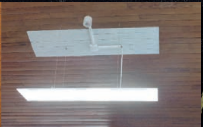
Luminaires : Les luminaires à leds s'ajustent en fonction de la luminosité extérieure.
