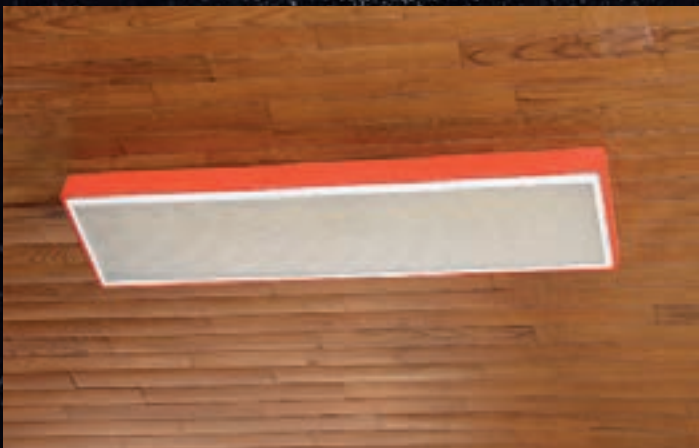
Luminaires : Les luminaires à leds s'ajustent en fonction de la luminosité extérieure.
